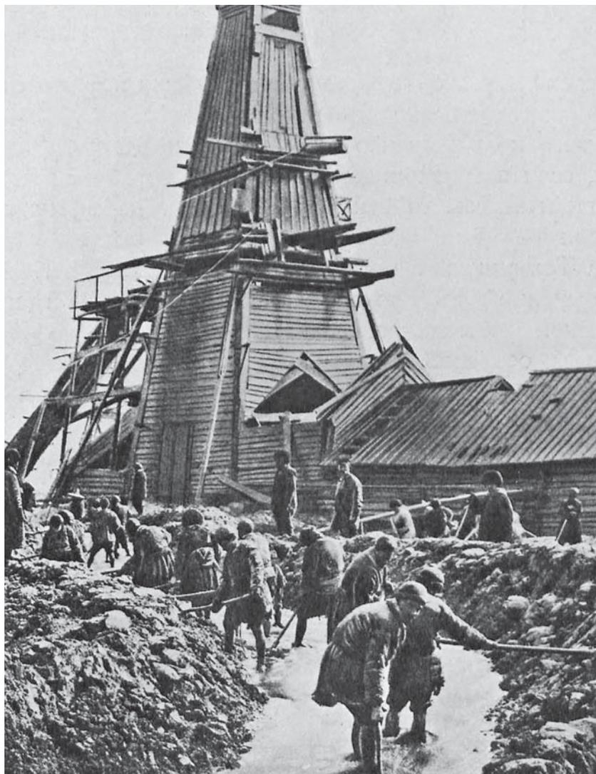
Работа у фонтанирующей скважины: очистка нефтяных ям
