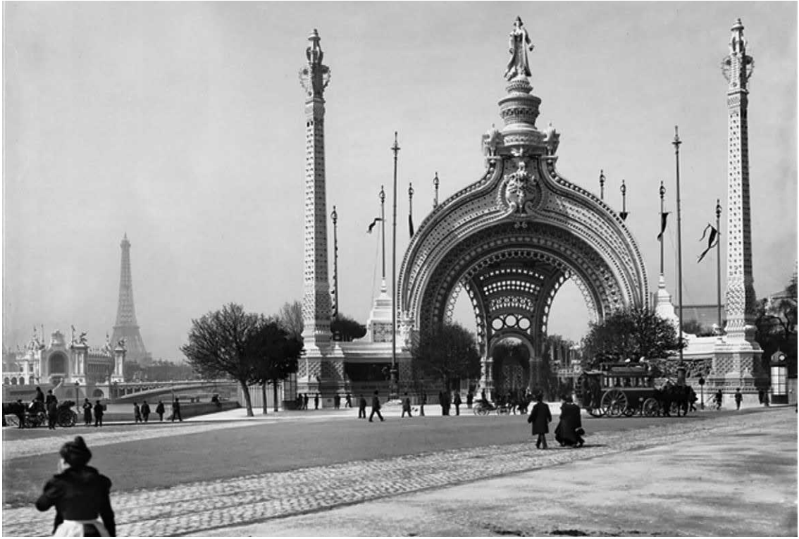
Классический пример влияния работ Геккеля на архитектуру — входная арка Рене Бине на Всемирной ярмарке в Париже. 1900 г.
